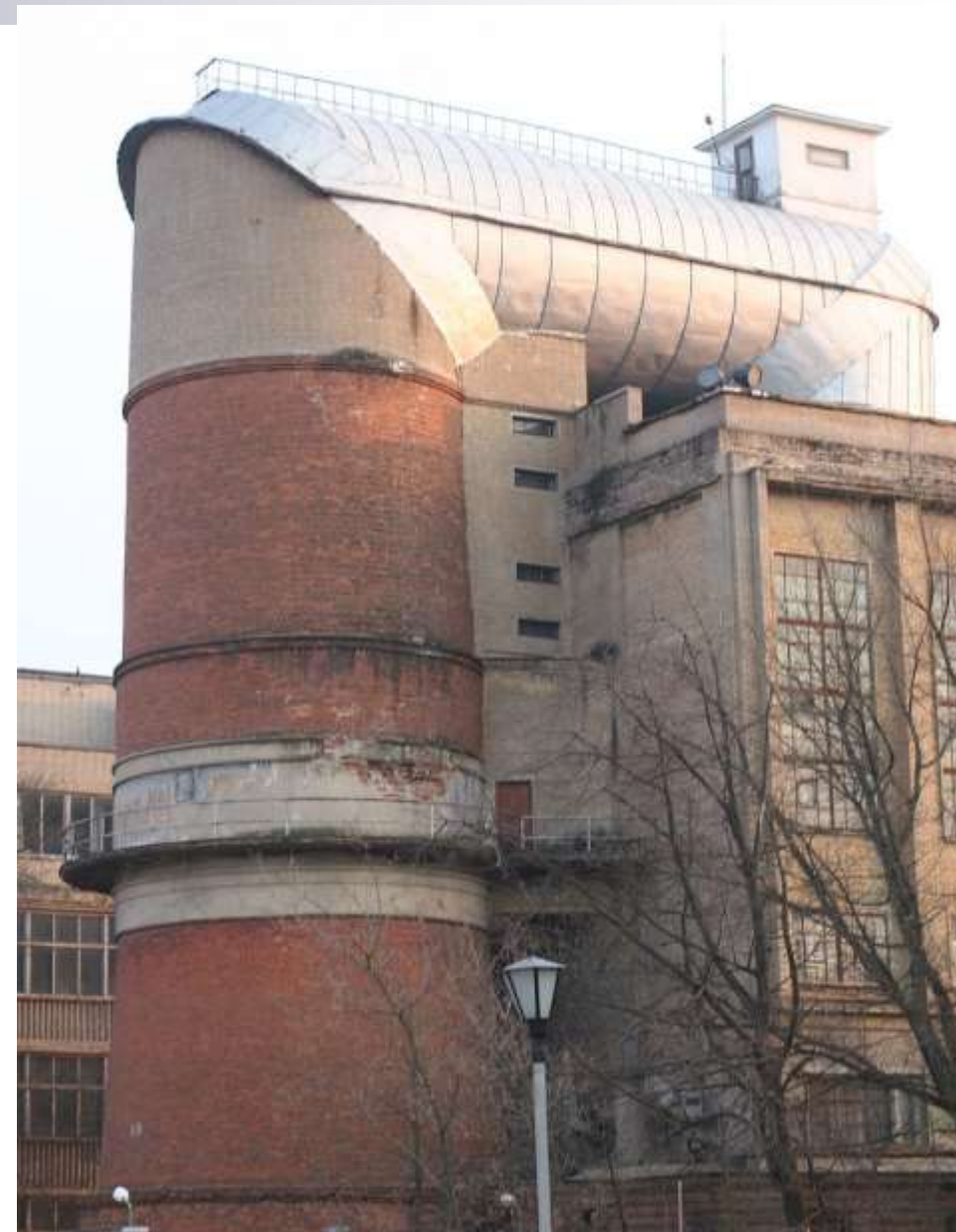
Вертикальная аэродинамическая труба ЦАГИ. Постройка 1945
