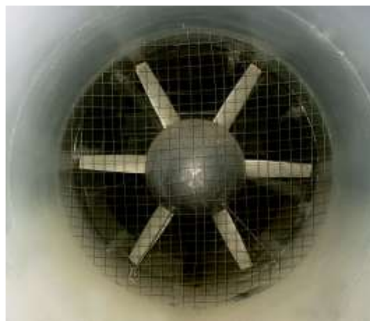
Импеллер нагнетает воздух в трубу
