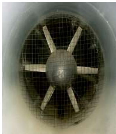
Импеллер нагнетает воздух в трубу
